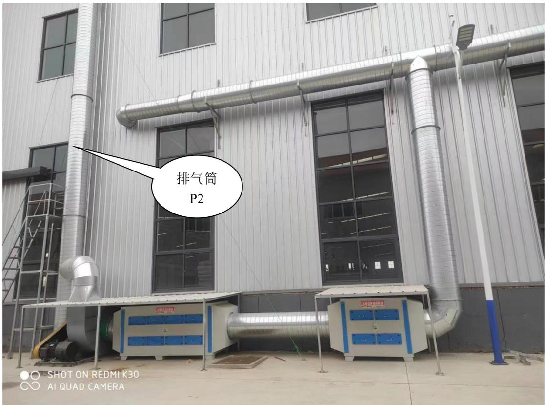
图 4 两级活性炭吸附装置+排气筒 P2
